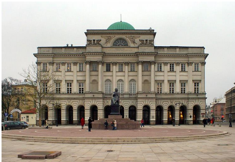
Pałac Staszica w Warszawie, siedziba PAN
